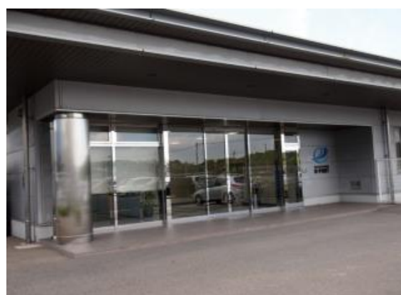
<e-PORT データセンター>
